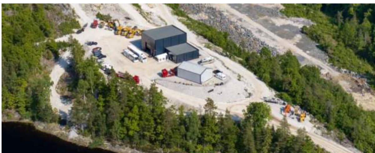
Figur 2-2 Kontor og verksted
