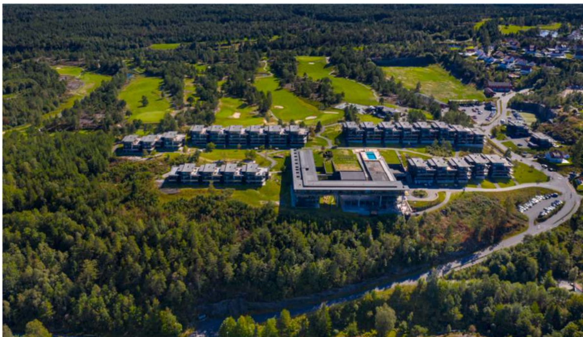
Figur 3-3. Oversiktsbilde fra nord
