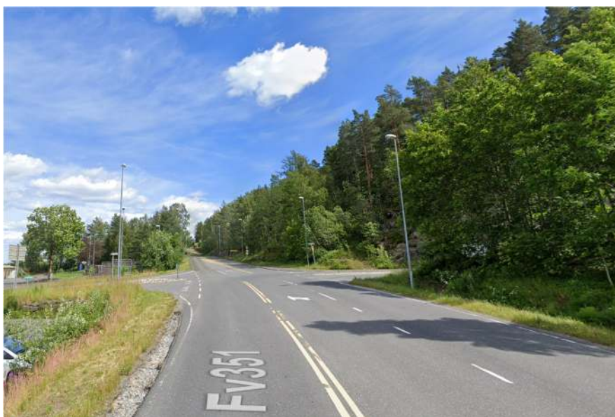
Figur 6-61. Kryss fv. 351 og Stabbestadveien
