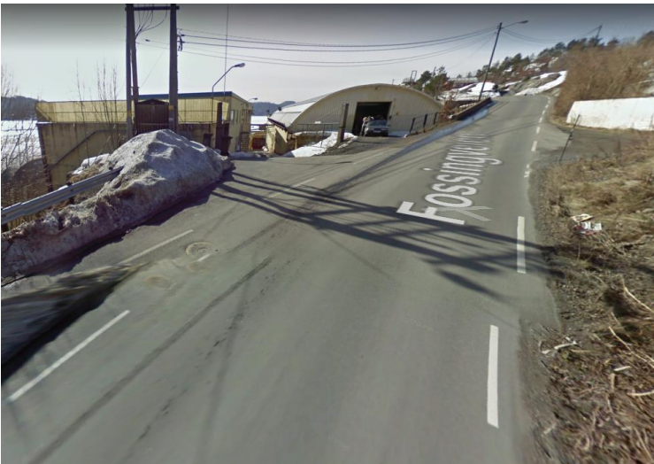
Figur 6 Fv 3362 retning vest. Denne avkjørselen til industriområdet stenges. Privat avkjørsel på motsatt side videreføres (Foto: Google Street View).
