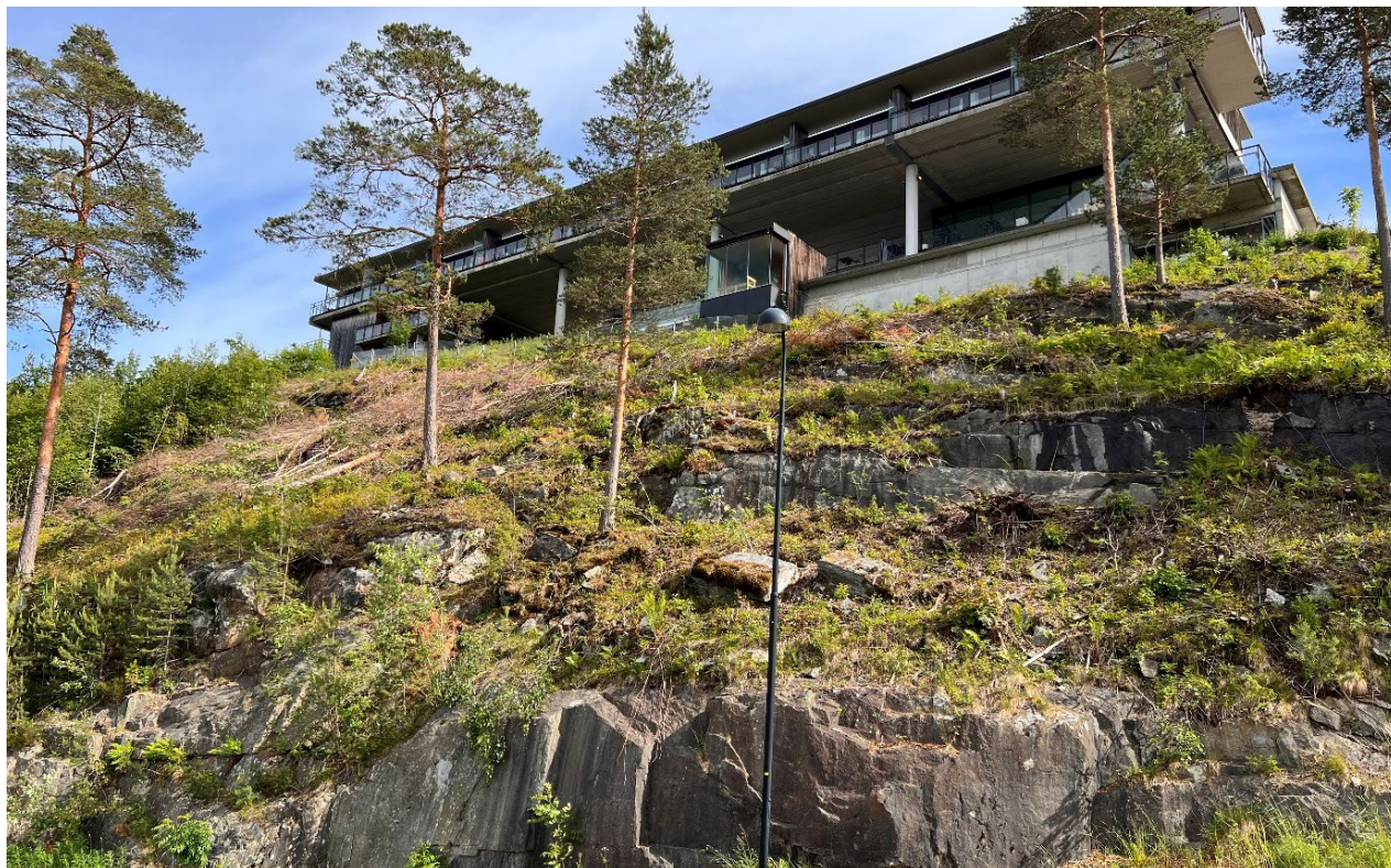
Figur 2. Bilde fra adkomstveien mot hotellet, tatt på befaring den 15.06.2022
