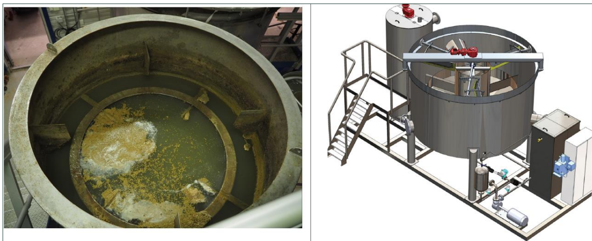
Figur 12: Flokkuleringstank på Stabbestad RA (venstre) og den nye utgaven av Musling (høyre)
